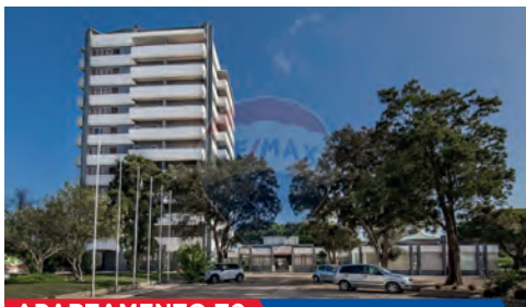
APARTAMENTO TO ID: 124081028-120 Portimão | Alvor 100.000 €
